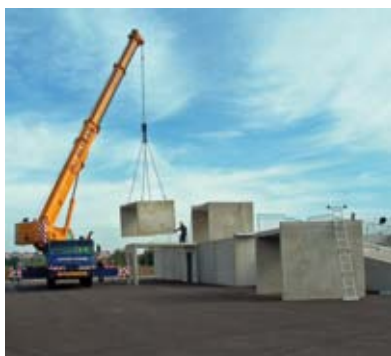
Stavba sběrného dvora
