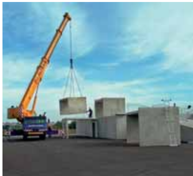
Строительство двора для сбора отходов
