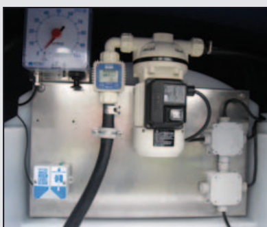
pohľad do strojovne
