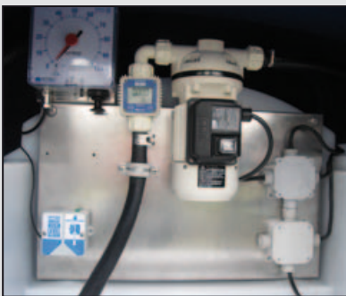
Vue de la salle des machines
